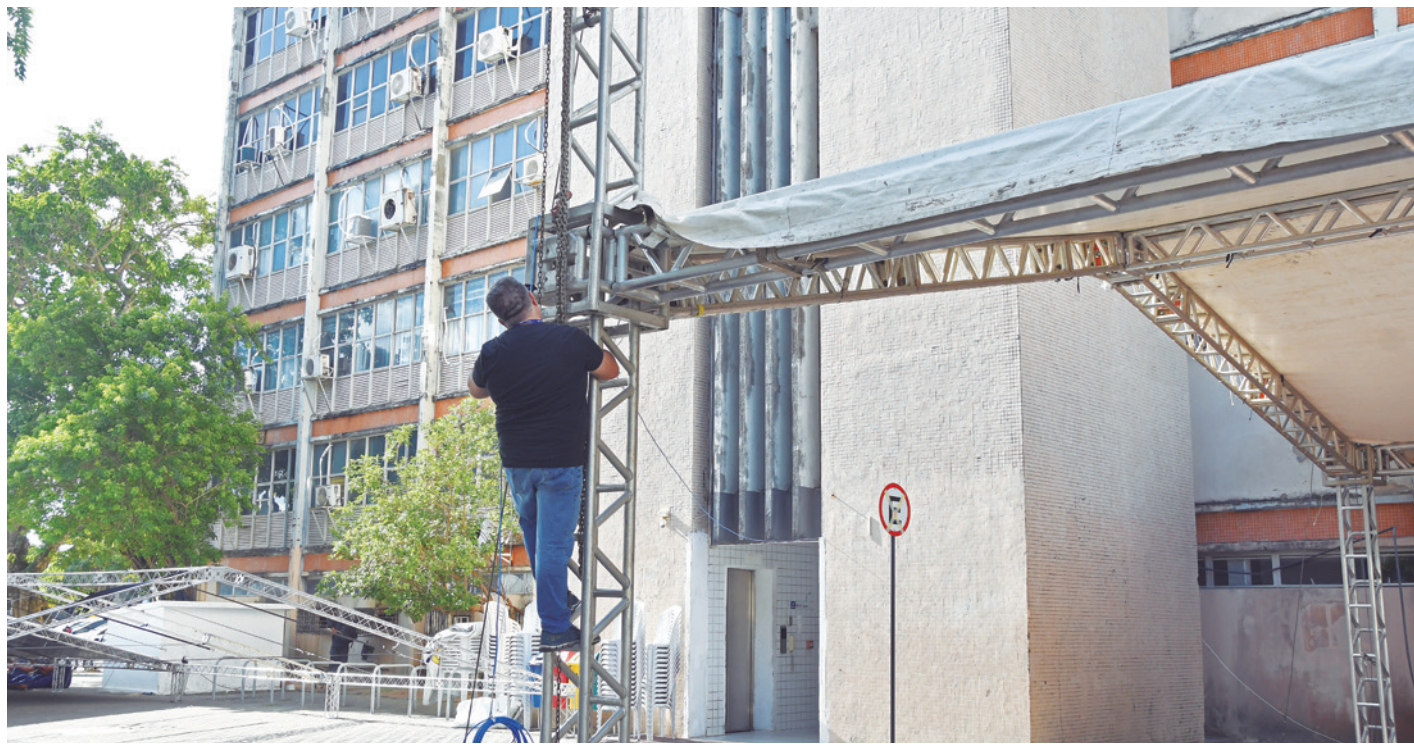
Estruturas do evento foram montadas na área externa do Centro Administrativo Estadual, localizado no Bairro de Jaguaribe
